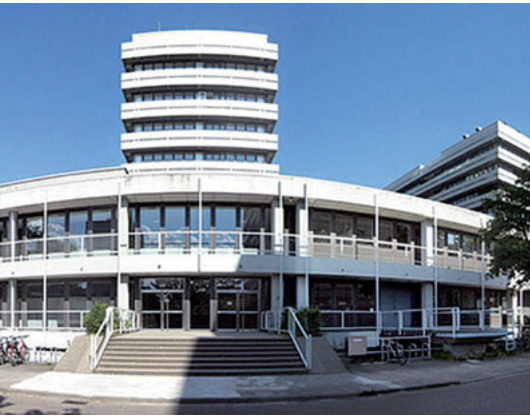
Der Flachbau vor dem Bioturm ist noch stärker PCB-belastet.
